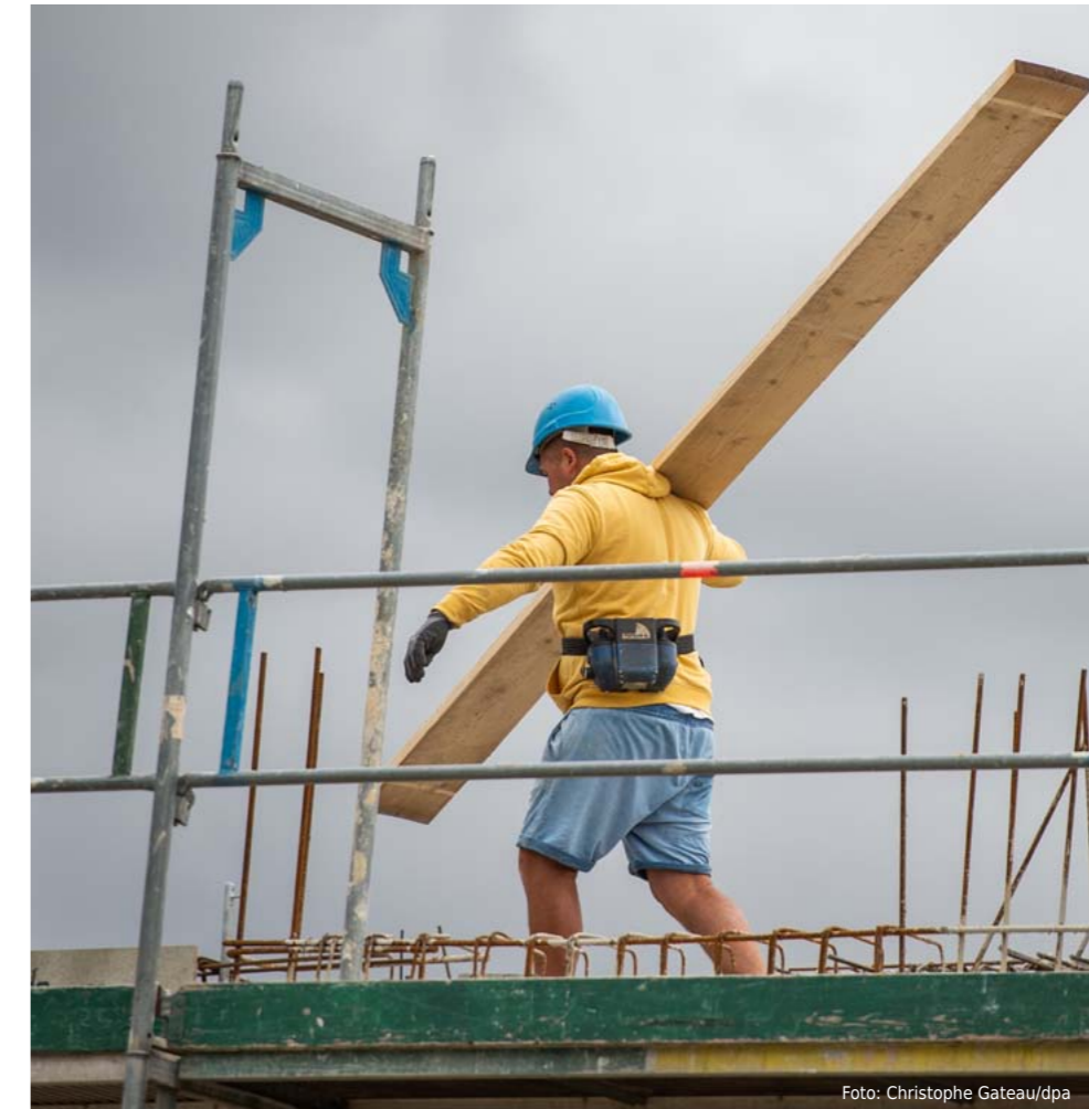
Ein Bauarbeiter trägt auf einer Baustelle auf einem Hausdach ein Brett. Die deutsche Wirtschaft hat im zweiten Quartal nach Einschätzung von Ökonomen einen deutlichen Dämpfer erhalten.
