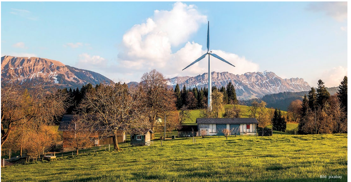
Ein Windrad steht selten allein. Meistens gibt es ganze Windparks, die für nachhaltige Energieerzeugung sorgen.
