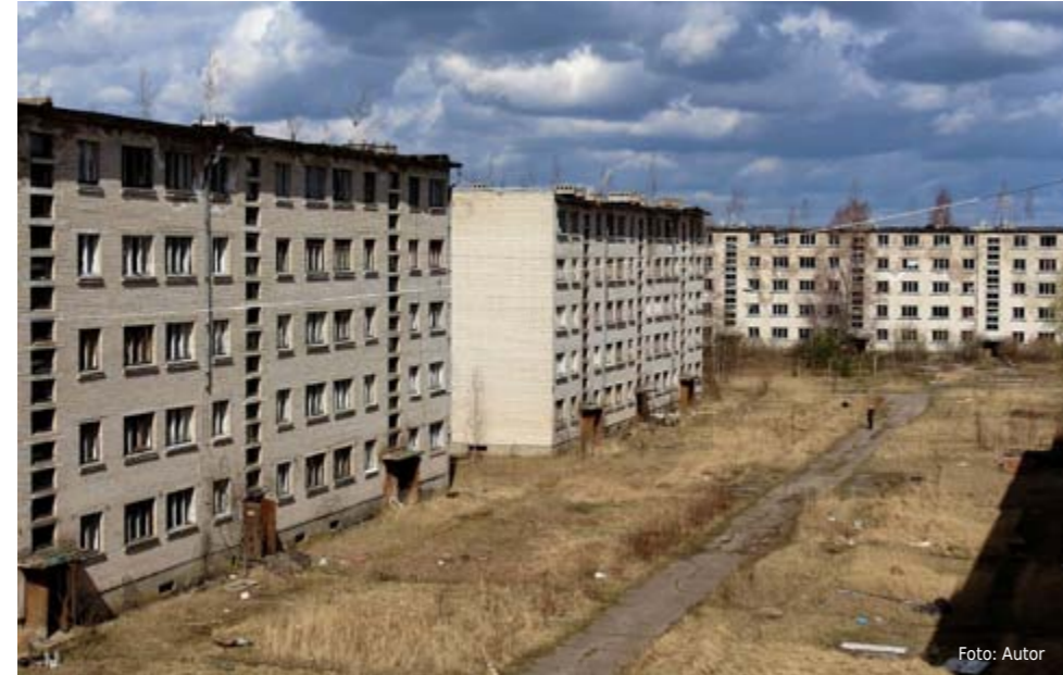
Blick auf die verlassenen Wohnblöcke.
