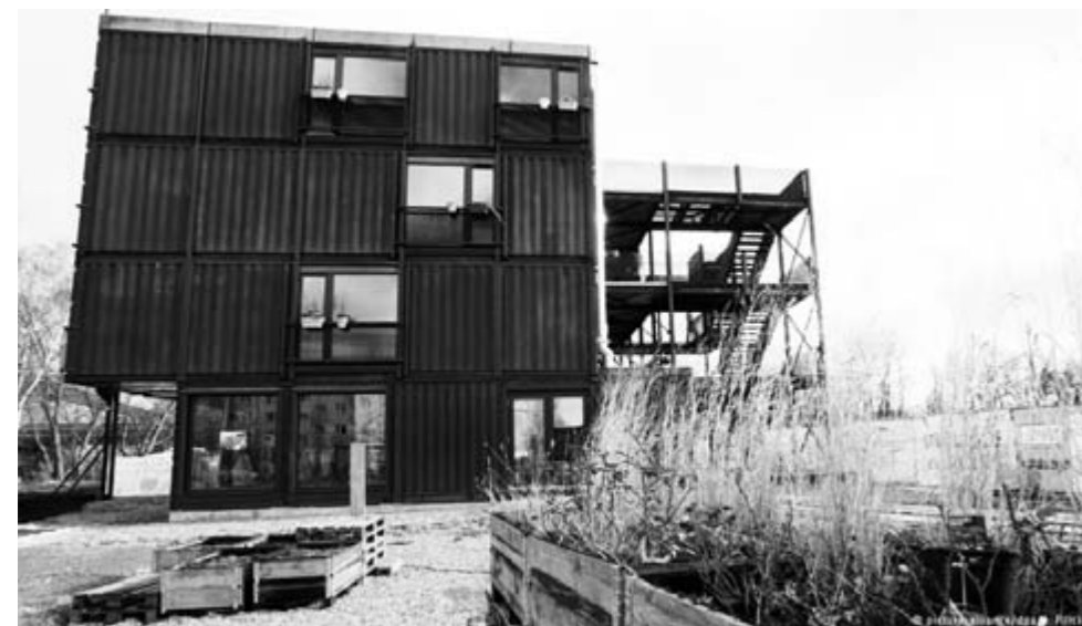
In vielen Städten ist günstiger Wohnraum knapp. In Berlin werden Studierende auch in Containerdörfern untergebracht.
