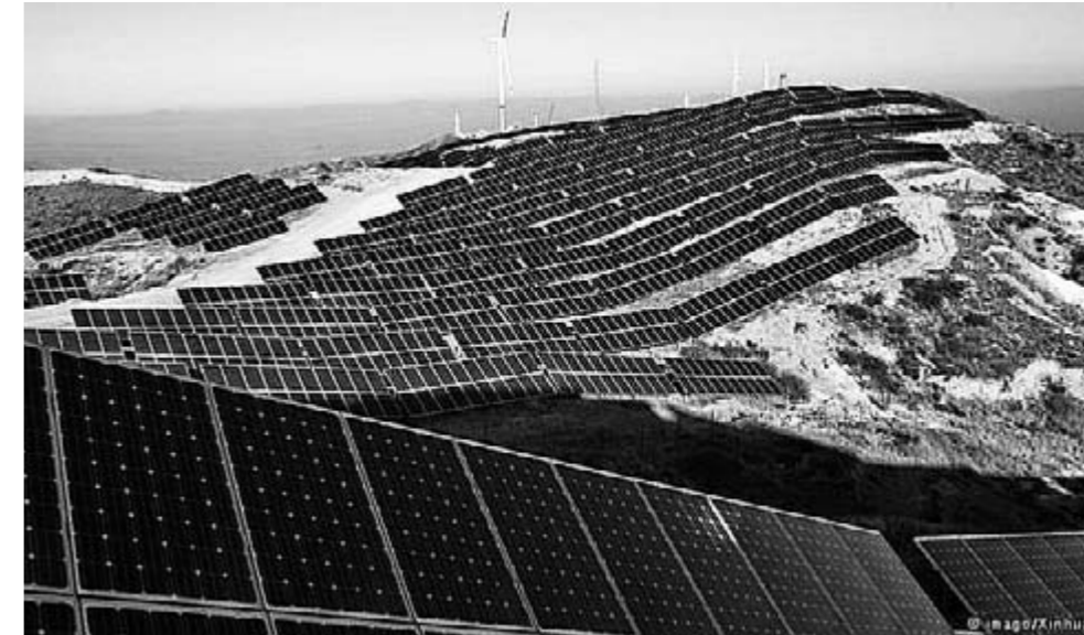
Solar- und Windpark in Zhangjiakou.
