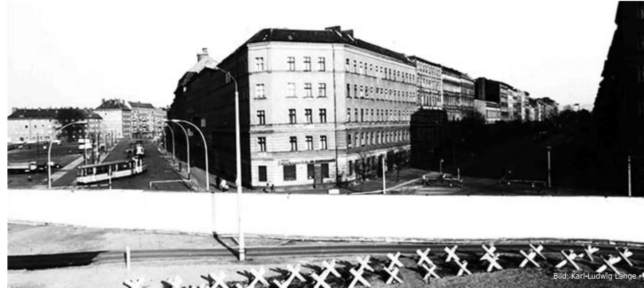
Bernauer Strasse, Blick auf Eberswalder Strasse, Grenzanlage Wedding/Prenzlauer Berg. 1973.
