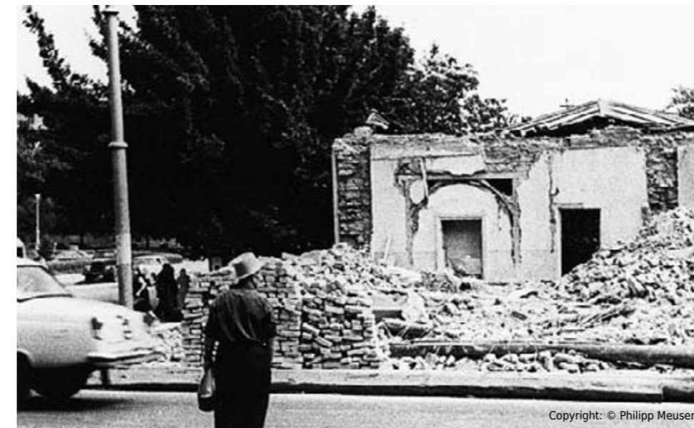
Zerstörung nach dem Erdbeben vom 26. April 1966
