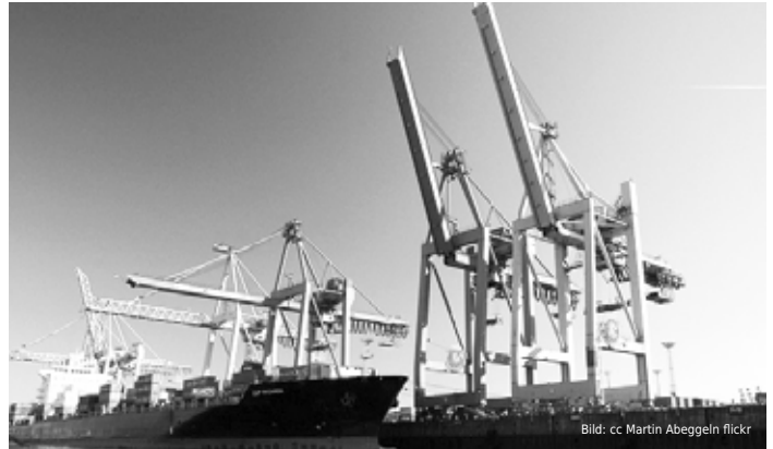
Ein Großteil des Hamburger industriellen Energiebedarfs entfällt auf den Hafen.
