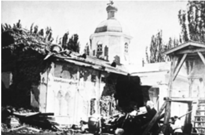
Никольский собор в районе Большой станции после землетрясения.
