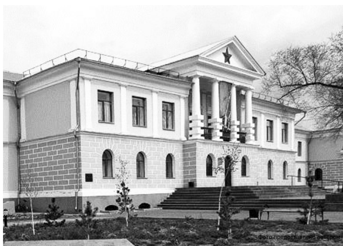
Здание Управления Карлага НКВД СССР. Современный вид.
