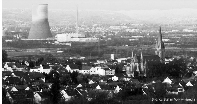
Laut Schätzungen soll die Abwicklung des Kernkraftwerkes in Mülheim-Kärlich mindestens 750 Millionen Euro kosten.
