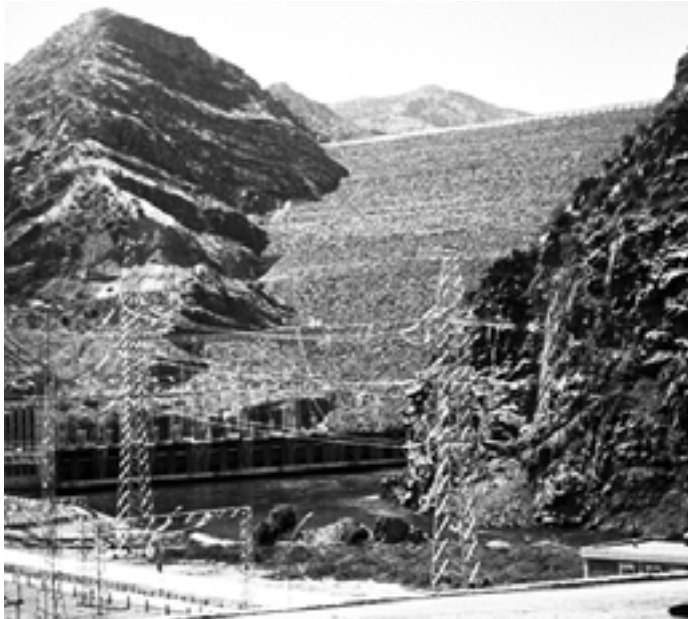
Das Kraftwerk Nurek muss Erderschütterungen standhalten.
