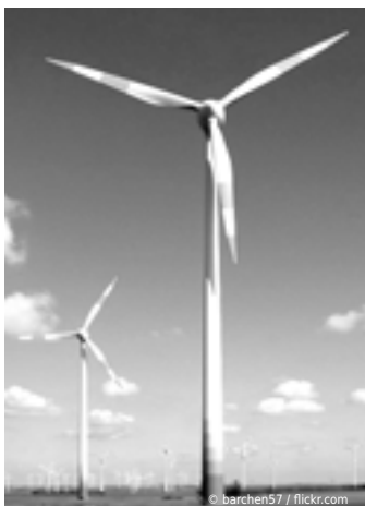
Energiewende: Die begehrten Rohstoffe werden für die Herstellung von Windrädern benötigt.
