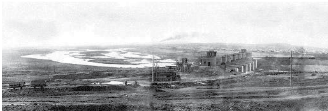
Вид на гидроузел. Идёт заполнение водохранилища.
