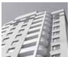
2. көп пәтерлі үй - Mehrfamilienhaus, n
