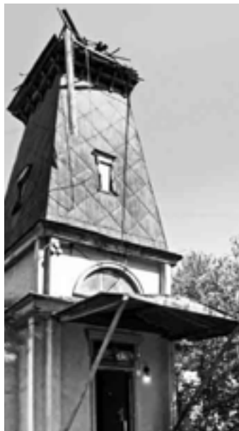
Верненская метеостанция после реконструкции.
