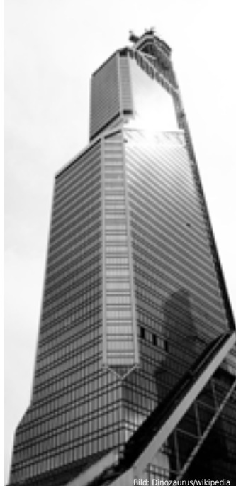
Der Mercury Tower kurz vor der Fertigstellung.
