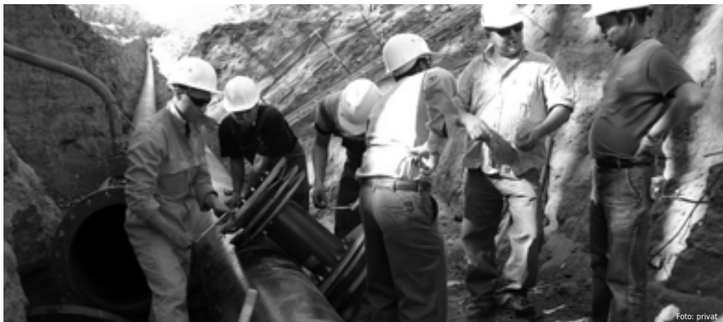
Auftrag erfüllt: Die Mitarbeiter von ZhaikTrubTech holen einen Molch aus der Pipeline.
