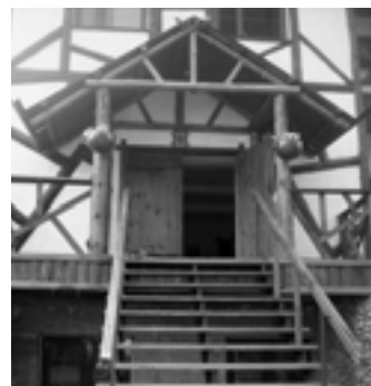
8. крыльцо – Außentreppe, f
