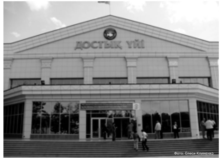
Дом дружбы в г. Павлодаре.
