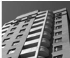
2. көп пәтерлі үй – Mehrfamilienhaus, n
