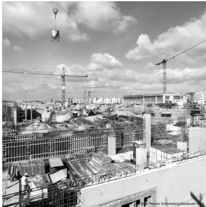
Bis Herbst 2011 sollen mehr als 2.000 Arbeiter Berlins neuen Flughafen fertig stellen.
