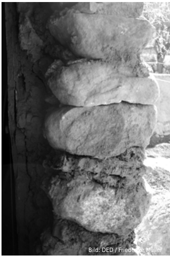
Außenwand eines Pamirhauses: Stein und Lehm gegen frostige Wintertage mit minus 20 Grad und kälter.
