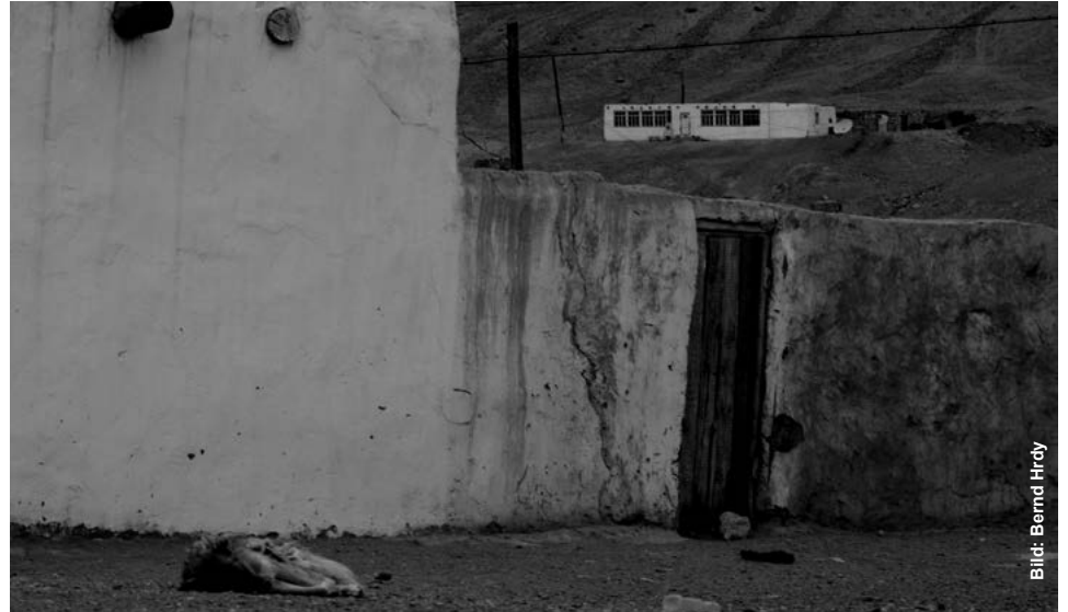
In Zentralasien Standard – in Europa wiederentdeckt: Lehm als Baustoff.
