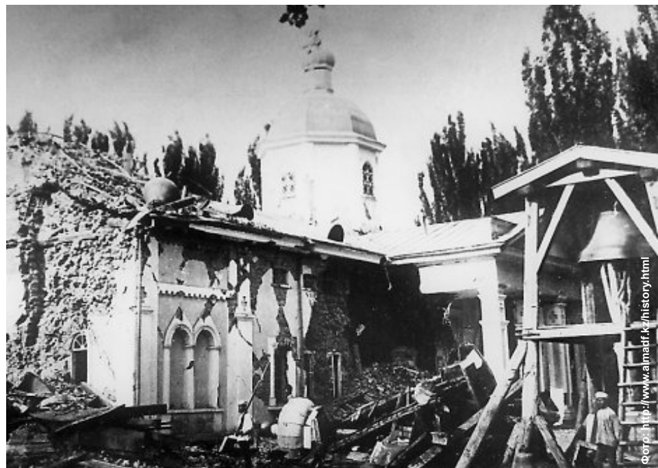
Покровская церковь после землетрясения 1887 года.
