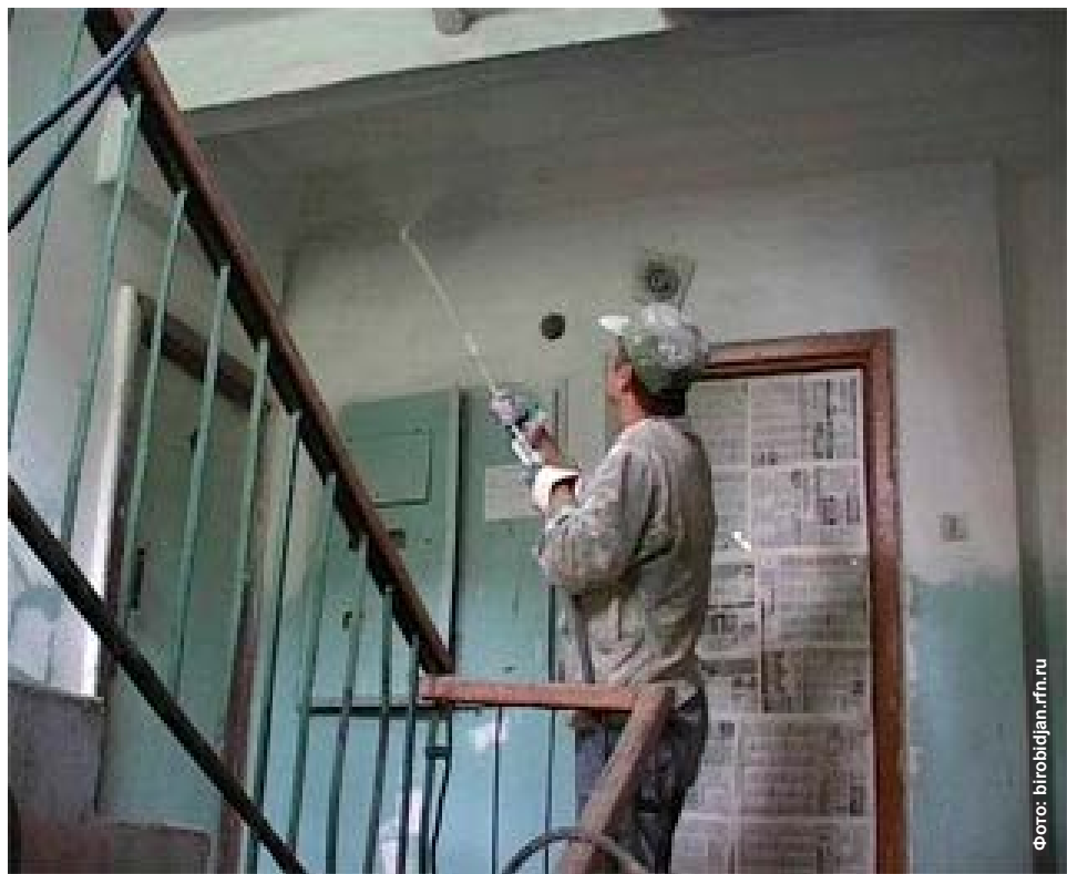
Ремонт подъезда своими силами.
