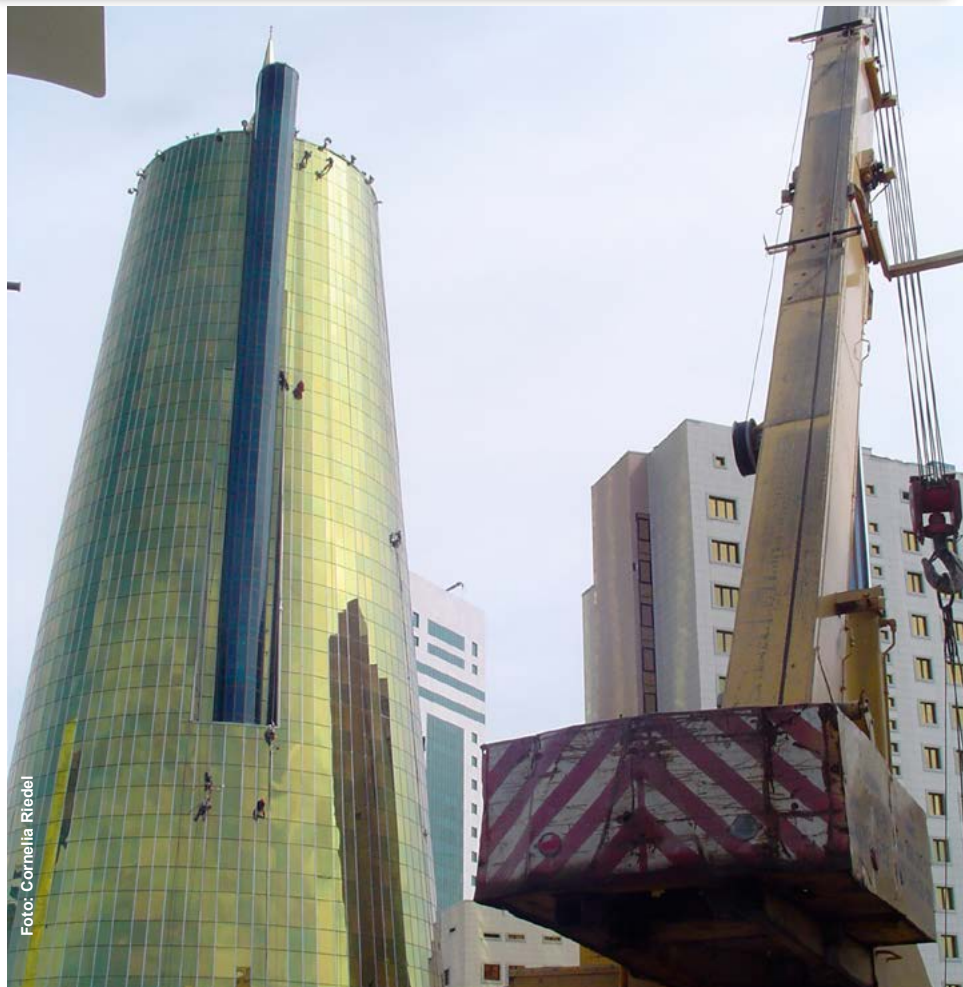
Ein Ministeriumsgebäude in Astana. Immer noch ist die Hauptstadt Kasachstans voller Baufahrzeuge.
