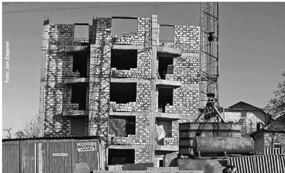
Eine Bauruine in Chisinau.
