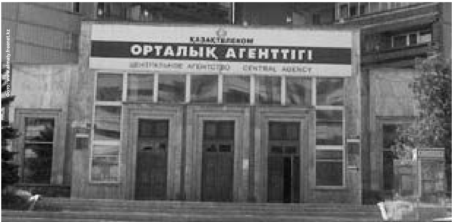
Здание «Казхтелкома» в Алматы
