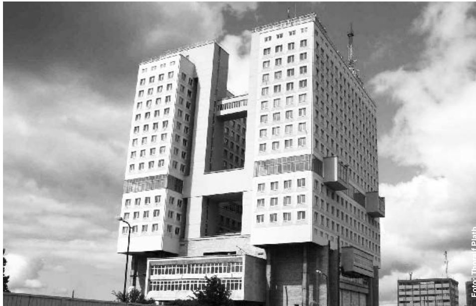
Auf dem derzeit brachliegenden Schlossplatz steht das Betonungetüm „Dom Sowjetow“.
