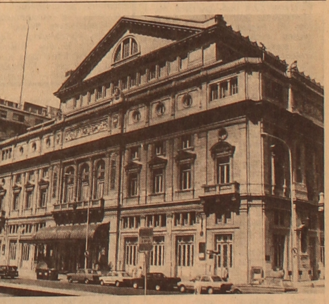
Argentinien. Das führende südamerikanische Opernhaus, ist das Teatro Colon (Kolumbustheater) in Buenos Aires. Das wegen seiner hervorragenden Akustik bekannte Bauwerk wurde 1908 von italienischen Architekten im italienischen Neo-Renaissance-Stil errichtet. Der berühmte italienische Tenor Enrico Caruso (1873—1921) begeisterte Anfang des XX. Jahrhunderts das Publikum in diesem Hause. Foto: ADN
