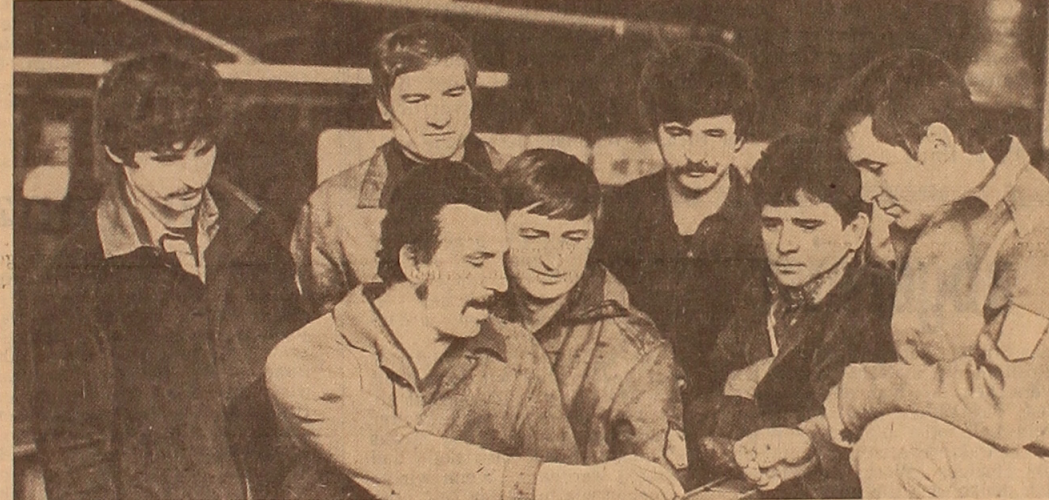
Das Kombinat „Agrostroj“ in Zelinograd versorgt mit seinen Erzeugnissen die Stahlbeton- und Wohnungsbaukombinate. Jeden Tag kommt immer mehr Arbeit hinzu.
