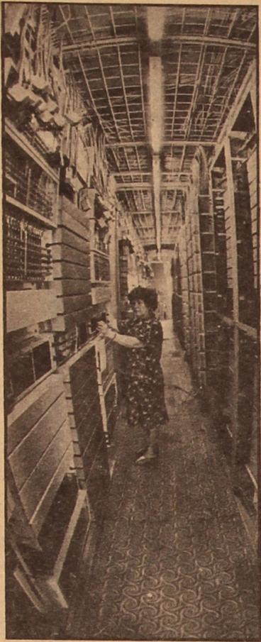
Полным ходом идет монтаж оборудования на новой телефонной станции АТС-4 в Уральске. Его ведет коллектив специализированного строительного-монтажного управления № 3 треста «Казтелефонстрой». А оборудование для станции поставлено из Чехословакии по линии СЭВ. С ее вводом емкость телефонной сети в областном центре увеличится еще на десять тысяч номеров.
