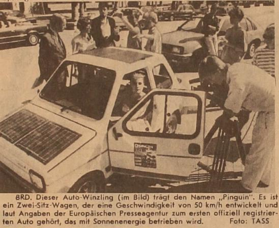
BRD. Dieser Auto-Winzing (im Bild) trägt den Namen „Pinguin“. Es ist ein Zwei-Sitz-Wagen, der eine Geschwindigkeit von 50 km/h entwickelt und laut Angaben der Europäischen Presseagentur zum ersten offiziell registrierten Auto gehört, das mit Sonnenenergie betrieben wird. Foto: TASS
