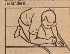
Die handelsüblichen Fußbodenbeläge sollten etwa 4 Tage lang im dem betreffenden Raum auseinandergelagert ausliegen, damit er sich entspannen kann. Dann wird der Belag in Länge geschnitten, daß sich die Bahnen ungelegt, daß sich die Bahnen um etwa 20 mm überlappen. Mit einem Spachtel ist der Klebstoff auf dem Untergrund gleichmäßig zu verteilen. In dieses vorbereitete Klebstoffbett wird dann der Belag eingelegt.
