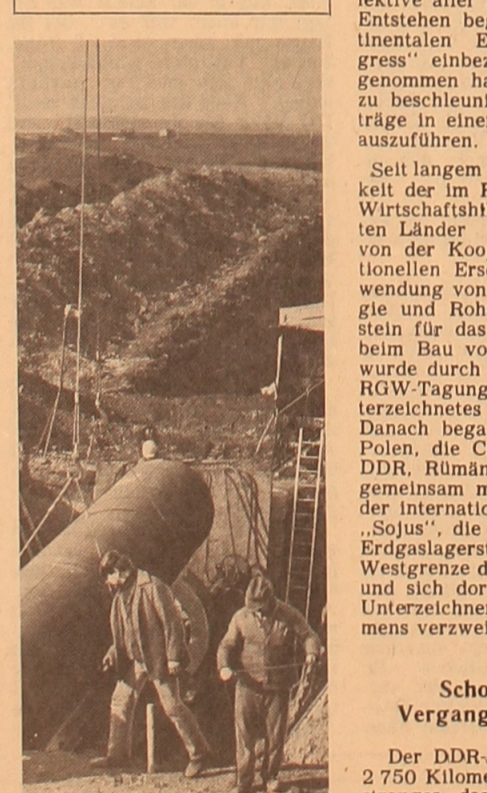
DDR-Spezialisten beim Bau einer Erdgasleitung in der Nähe von Lipetsk
