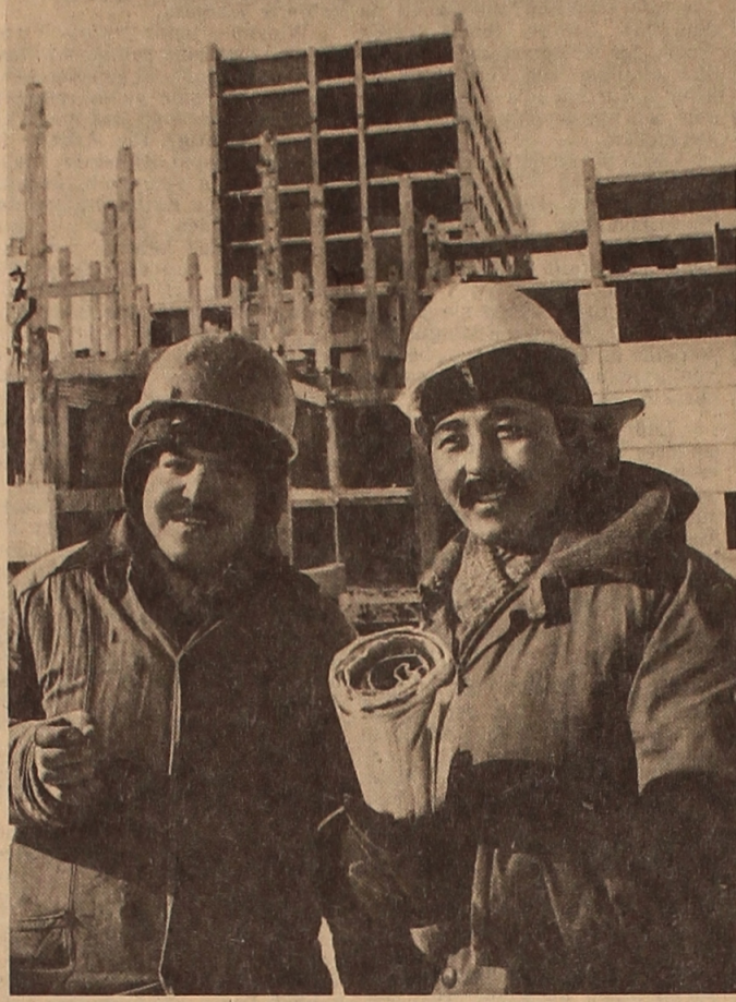
In Dsheskasgan ist ein allgemeines Krankenhaus im Bau begriffen, in dem Abteilungen für Chirurgie, innere und Infektionskrankheiten sowie eine Poliklinik und verschiedene Hilfseinrichtungen untergebracht werden sollen.
