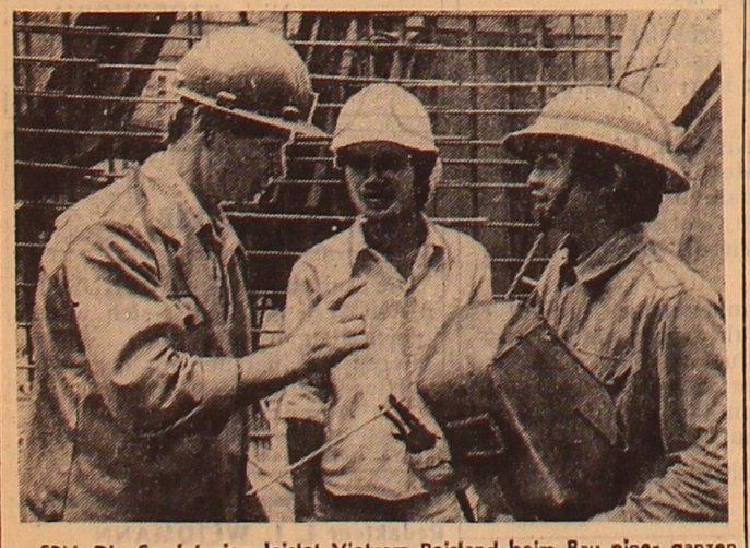
SRV. Die Sowjetunion leistet Vietnam Beistand beim Bau einer ganzen Reihe von Energieobjekten. Eines davon ist der Wasserbaukomplex Hoabinh am Schwarzen Fluß — ein Objekt, das den vietnamesischen und sowjetischen Spezialisten komplizierte ingenieur-technische Lösungen abverlangt hat. Unser Bild: Der sowjetische Spezialist B. Abakumow unter vietnamesischen Elektroschweißern. Foto: TASS
