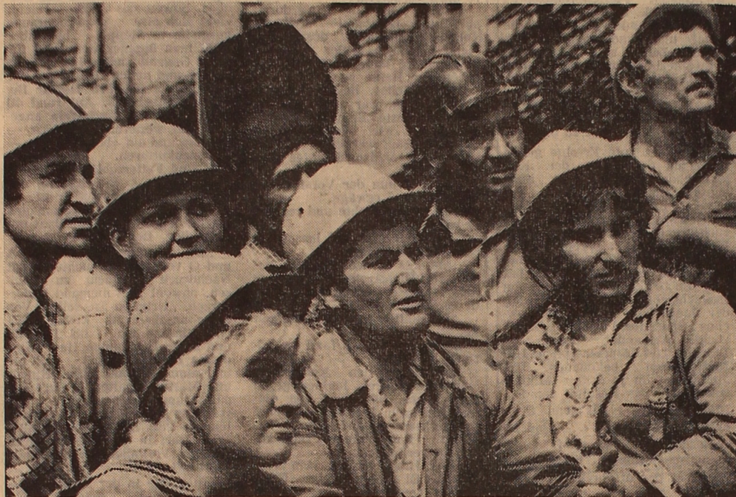
GEBIET SEMIPALATINSK. Der Bau des Schulba-Wasserkraftwerks ist in seine neue Etappe getreten. In vollem Gang sind die Arbeiten beim Bau der Betonbettungen, auf die Turbinen aufgestellt werden sollen.
