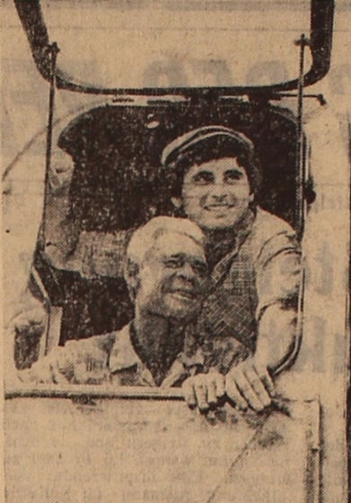
Im Gebiet Pawlodar hat die Errichtung einer neuen Bewässerungsmagistrale begonnen: Die Baubrigaden des Trüsts „Pawlodarstroi“ arbeiten am neuen Kanal Irtysch—Uspenka, der bereits im nächsten Jahr seiner Bestimmung übergeben sein soll.
