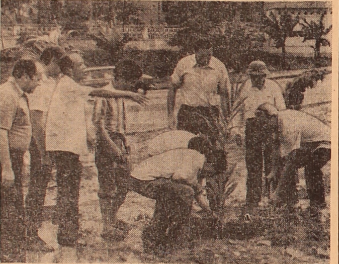
SRV. Mit jedem Tag schöner wird die vietnamesische Siedlung Hoa Binh am Schwarzen Fluß in der Provinz Ha Son Binh. Dort wird unter technischer Mithilfe der Sowjetunion der größte Wasserbaukomplex nicht nur Vietnams, sondern auch ganz Südostasiens gebaut. Es entstehen neue Betriebe dieses Bauvorhabens — das Betonwerk und die Reparaturwerkstätten, Kraftwagenzentralen und Kompressorstationen, eingerichtet wird die Siedlung der sowjetischen Spezialisten, werden Schulen und Kindergärten gebaut. Laut Plan der wirtschaftlichen Entwicklung Vietnams soll der Wasserbaukomplex Hoa Binh mit einer projektierten Kapazität von 2 Millionen Kilowatt im laufenden Planjahr fünf anlauffertig werden. Im Bild: Beim Anlegen der Allee der Freundschaft in der Siedlung sowjetischer Spezialisten. Foto: TASS
