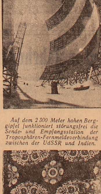
Auf dem 2 300 Meter hohen Berggipfel funktioniert störungsfrei die Sende- und Empfangsstation der Troposphären-Fernmeldeverbindung zwischen der UdSSR und Indien. Fotos: TASS
