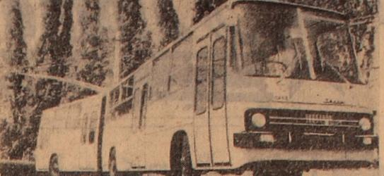
In der Ungarischen Volksrepublik ist ein neuer Typ der Gelenkbussen „T-6“ (im Bild) entwickelt worden. Das stufenlose Thyristorsystem sichert einen gleichmäßigen Lauf. Dank dem zusätzlichen Verbrennungsmotor fährt die Maschine durch Straßen, in denen es keine Fahrleitungen gibt. Foto: TASS
