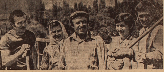
Die Baubrigade von W. Korostinski aus dem Bau- und Montage- des Traktors „Kasachstan“ vorbereitet auf ihrem Arbeitsplatz im Jahre 1980 und steht ihrem Ziel, das Planjahrfrüht in 4 Jahren zu erfüllen, ganz nahe.
