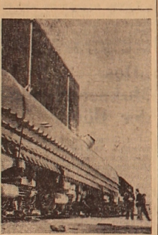
Erfolgreich entwickelt sich die ökonomische Zusammenarbeit zwischen dem Sozialistischen Jugoslawien und der Sowjetunion. Im Werk für Wärmeapparatur der Vereinigung „Energoinvest“ in Sarajewo wurde im Auftrag der UdSSR der erste Dampfabscheider für das Atomkraftwerk (im Bild) gebaut.
