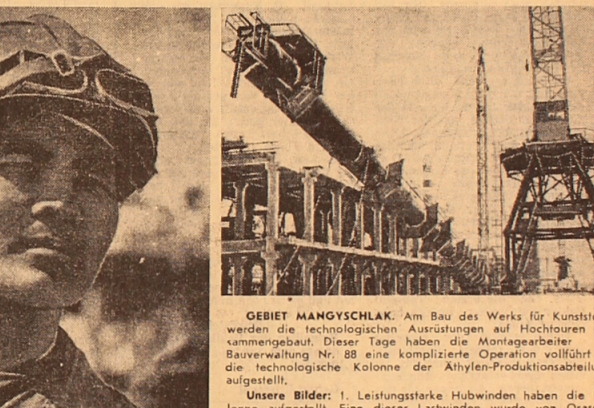
GEBIET MANGYSCHLAK. Am Bau des Werks für Kunststoffe werden die neuesten Ausrüstungen auf Hochtoren zusammengebaut. Dieser Tage haben die Montagearbeiter der Bauverwaltung Nr. 88 eine komplizierte Operation vollführt — die technologische Kolonne der Aihlen-Produktionsabteilung aufgestellt.
