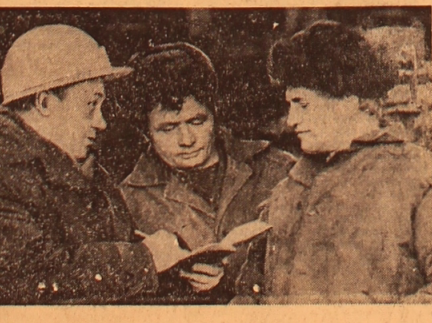
Das Montagepersonal und Schlosser, die die Montage des zehnten Großkraftwerks Jekaterina Mersikina, der Arbeiterleiter Nikolai Ungjanar, der Ingenieur Wasilij Jassakow, der Schlosser Alexander Bairamow und der Schweißer Nikolai Ulfonjischew...
