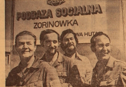
Auf dem polnischen Abschnitt der Pipeline Orenburg — Westgrenze der UdSSR, der von Socharnowka (Gebiet Rostow) bis Kremenschnog (Gebiet Paltawa) verläuft, sind die Rohre am 100. Kilometer in der Nähe der Siedlung Nowoposk, Gebiet Woroschilowgrad, geschweißt worden. Im laufenden Jahr haben die polnischen Spezialisten noch Dutzende Kilometer Rohre zu verlegen UNSER BILD: (v. l. n. r.) Polnische Bauarbeiter Adam Butajewicz, Stanislaw Kowka, Pawel Figurowski und Marian Mizera. Foto: TASS
