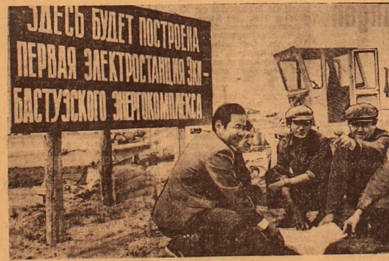
Hier wird ein neues Oberlandkraftwerk emporgewachsen.
