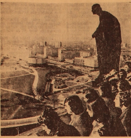
Eine Stadt der Neubauten eröffnet sich dem Blick der Touristen, wenn sie die Aussichtswarte des Dresdener Rathauses bestiegen. In den letzten dreißig Jahren wurden in dieser Bezirksstadt der Deutschen Demokratischen Republik 60 000 Wohnungen gebaut. Besonders intensiv entwickelte sich der Wohnungsbau im vergangenen Planjahrhundert.
