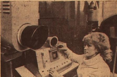
UNSER BILD: Das Gerät „Janta-MIT“ ist für die Diagnostik durch Fixierung der Wärmefelder, die auf der Leitwand der Kathodenröhre erhalten werden, bestimmt. Das Gerät wird für die Präzisierung besonders komplizierter Diagnosen angewandt.
